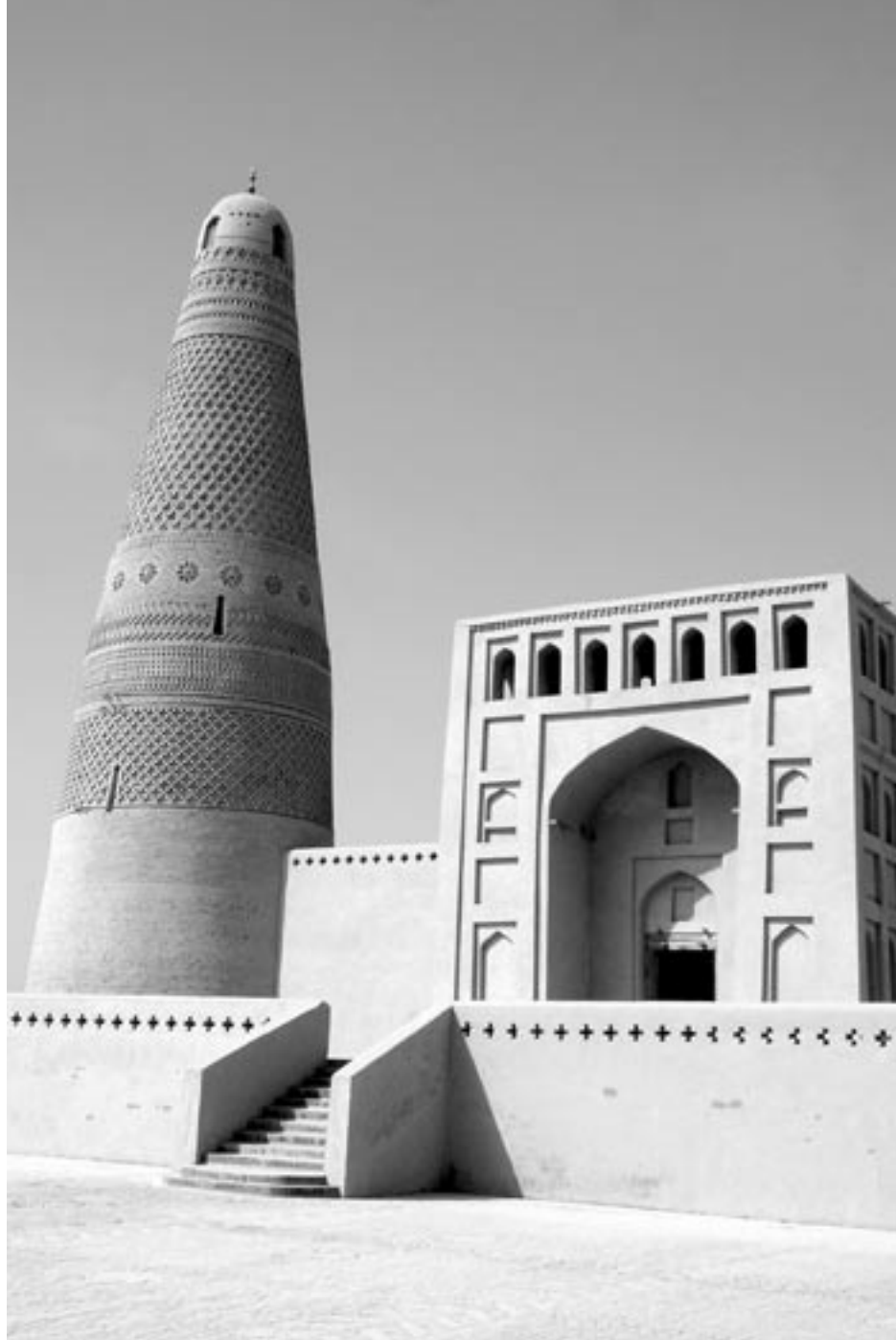
De Emin Hoja-moskee en minaret zijn volledig opgebouwd uit in de zon gebakken lemen stenen, een bekend bouw materiaal in de islamitische wereld
